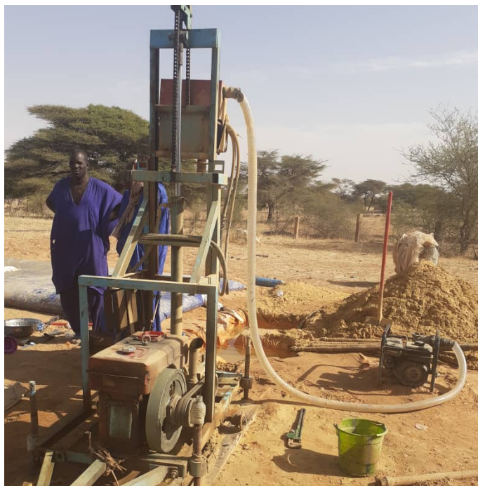
حفر تعاونية تولدي بيوكي كان دون جدوي اما في باكودين فاعطي ٣١٠ في الساعة و تم تجهيزه و تزويده بخزان سعة ٣١٦. Le forage de la coopérative de Toulde a Boghe n'était pas concluant, tandis que celui de la coopérative de Bagoudine à donné 10m3 heure et à été équipé et raccordé à un château d'eau de 16m3.
